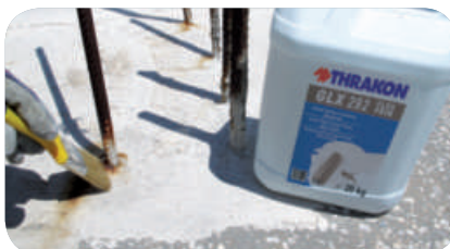
PASUL 4: Amorsați suprafața cu o amorsă cu putere mare de penetrare, GLX 292 FLEX PRIM .
