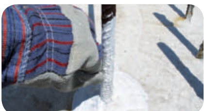
PASUL 6: În timp ce primul strat este încă umed, aplicați o fâșie de bandă de fibră de sticlă THRAKON .
