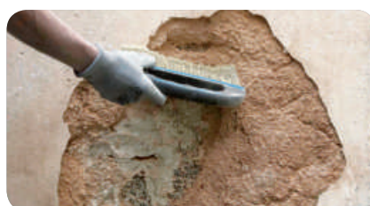
PASUL 1: Mai întâi, se îndepărtează cu o spatulă toate părțile sfărâmițoase ale tencuielii și se curăță cu o perie.
