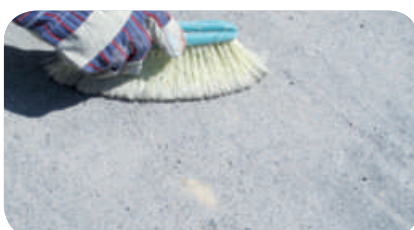
PASUL 1: Verificați dacă există mici crăpături pe suprafața pe care urmează să se facă aplicarea și curățați-le cu o perie.
