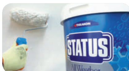
PASUL 7: Vopsiți suprafața cu STATUS ALL WEATHER , în două straturi.
