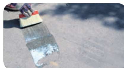
PASUL 2: Amorsați suprafața cu o amorsă cu putere mare de penetrare, GLX 292 FLEX PRIM .
