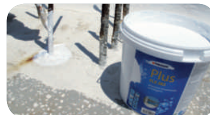
PASUL 5: Aplicați local FLX 380 ROOF SEALER la bază, până înălțimea de 10-15 cm.
