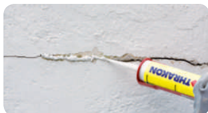
PASUL 4: Se aplică masticul de etanșare ELASTO PU , de-a lungul deschiderii fisurii.
