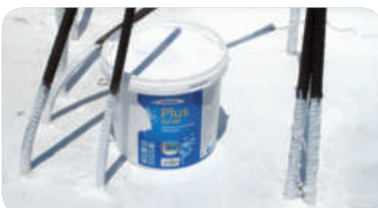
PASUL 7: Finalizați hidroizolarea aplicând încă două straturi de membrană acrilică pensulabilă FLX 380 ROOF SEALER .
