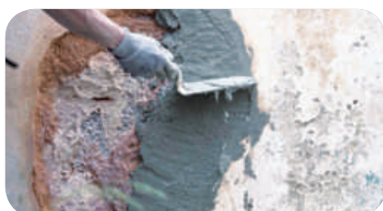
PASUL 3: Aplicați WRM 520 , care se întărește rapid, pe suprafața aplicării. Așteptați timp de 20 de minute ca să se usuce.
