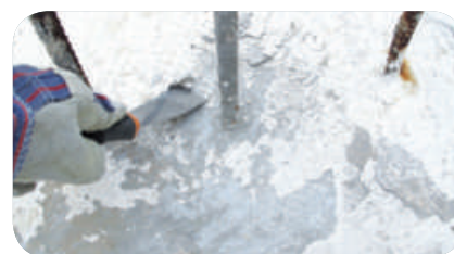
PASUL 2: Îndepărtați particulele libere cu un șpaclu.
