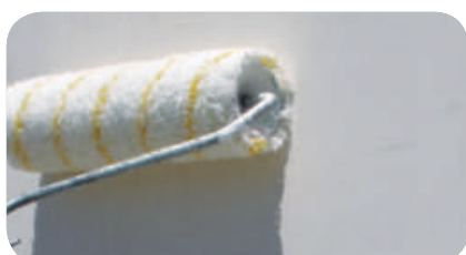
PASUL 6: Aplicarea amorsei cu putere mare de penetrare GLX 292 FLEX PRIM .
