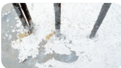
Dacă deja există o membrană acrilică aplicată, verificați existența particulelor libere.
