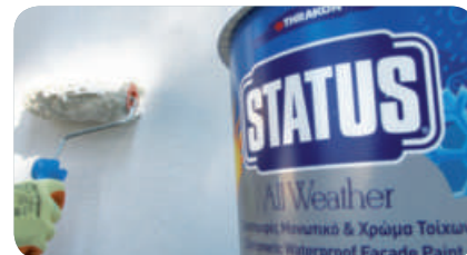
PASUL 6: Aplică STATUS POLYPRIMER pentru pregătirea suprafeței, înainte de aplicarea STATUS ALL WEATHER , o vopsea care este flexibilă și ideală pentru hidroizolarea pereților.
