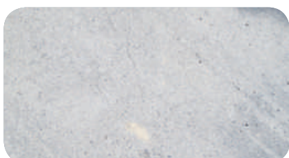
Atunci când există mici fisuri pe suprafața dalei de beton, acestea trebuie protejate pentru a se evita viitoarele probleme cu umiditatea.
