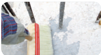
PASUL 3: Curățați bine suprafața de particule libere și de murdărie cu o perie.
