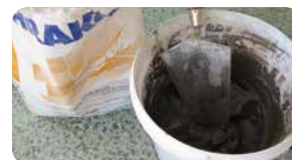
PASUL 3: După alegerea chitului de rosturi THRAKON FMF 160 , preparăm amestecul pe care îl aplicăm cu o gletieră de cauciuc.
