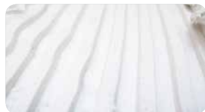
PASUL 1: Aplicați VKW 132 cu o gletieră adecvată (grosime).
