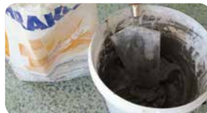
PASUL 2: Aplicați GLX 190 , amorsă pe bază de cuarț, pentru creșterea aderenței.
