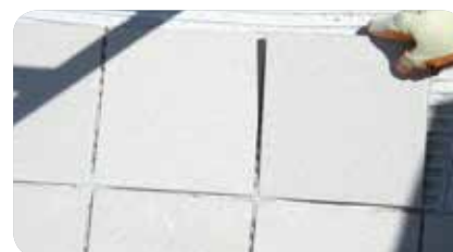
PASUL 4: Rosturile dintre plăcile ceramice pot fi stabilite ușor cu distanțierele speciale (+, T, Y).
