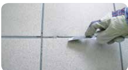
PASUL 1: Îndepărtați chit de rosturi în exces cu un șpaclu metalic.
