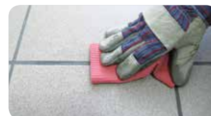
PASUL 4: După ce chit de rosturi s-a uscat, curățați suprafața cu un burete.
