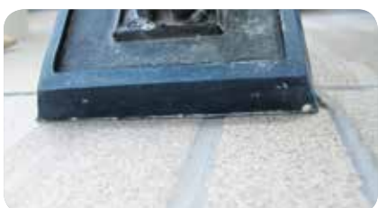
PASUL 4: După ce chit de rosturi s-a uscat, curățați suprafața cu un burete.
