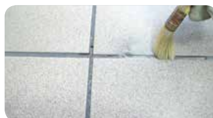
PASUL 2: Curățați bine suprafața de praf. Recomandăm curățarea ușoară cu apă.
