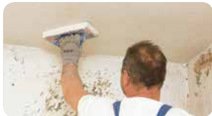
PASUL 11: Șlefuiți suprafața cu o gletieră cu burete.
