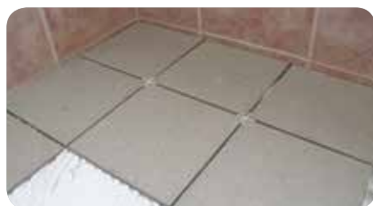
PASUL 2: Aplicarea plăcilor ceramice este rapidă și ușoară.
