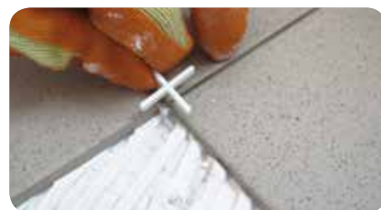
PASUL 3: Rosturile dintre plăcile ceramice pot fi cu ușurință fixate cu ajutorul distanțierilor (+, T, Y).
