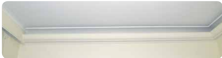
PASUL 10: Aplicați un strat de tencuială albă cu marmură NHP 250 .
