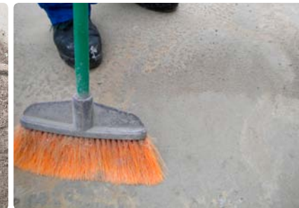
Καθαρισμός σαθρού υποστρώματος
