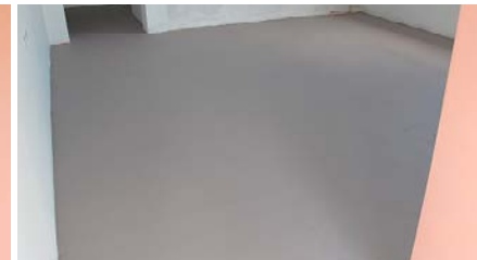
Όταν αυτό απαιτείται περνάμε περισσότερες στρώσεις, με λεία σπάτουλα
