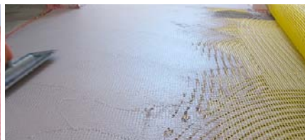
Στην πορεία χρησιμοποιούμε τη λεία σπάτουλα για την επιπέδωση της επιφάνειας
