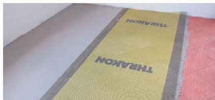
Το επόμενο πλέγμα θα εφαρμοστεί δίπλα στο άλλο, επικαλύπτοντας το κατά 10 cm
