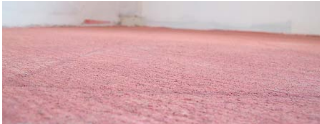
Αστάρωμα επιφάνειας (χαλαζιακό αστάρι)
